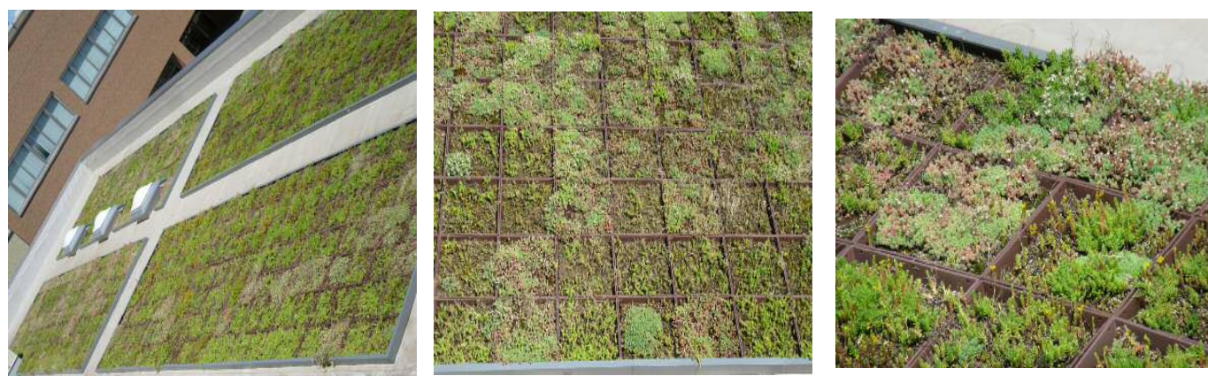
現在の敷地内院外薬局屋上(令和元年6月撮影)
