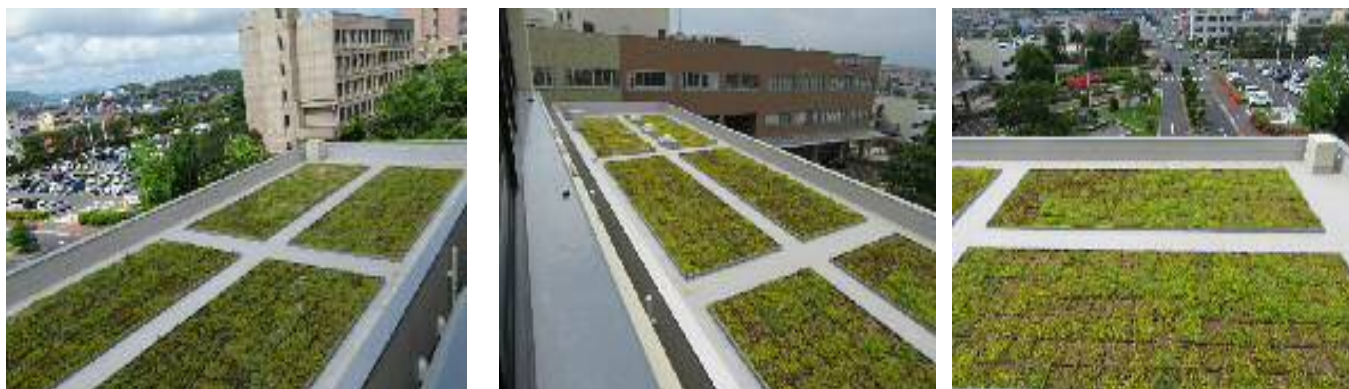
本部棟から見る敷地内院外薬局屋上(平成30年6月撮影)
