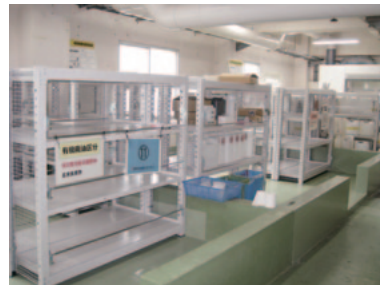
改修工事後の環境安全施設内
