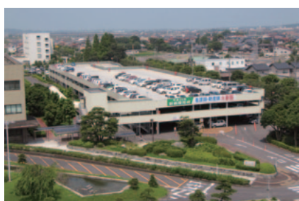
458台収容可能な立体駐車場
